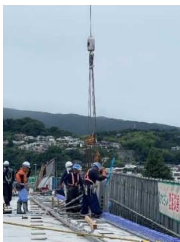
【プレキャスト壁高欄の設置状況】
