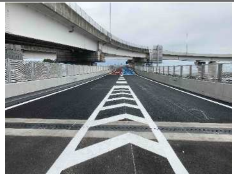
[萬丈橋下り線床版取替え完了 7月19日]
