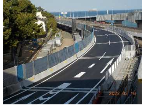
[萬丈橋下り線床版取替え完了 3月16日]
