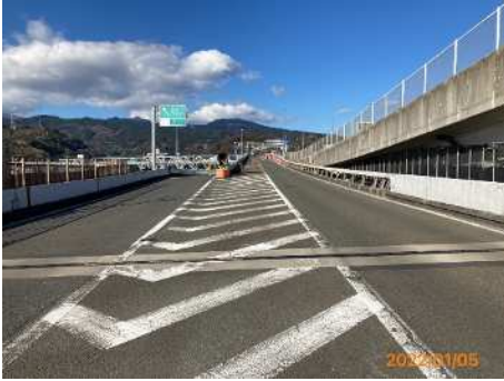
[萬丈橋下り線床版取替え前 1月5日]
