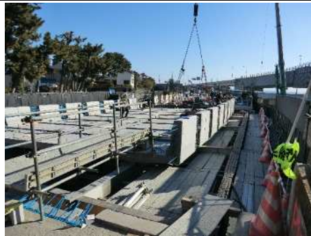
[萬丈橋下り線床版取替え状況 2月7日]
