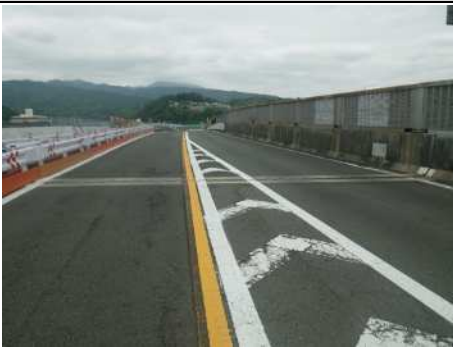
[萬丈橋下り線床版取替え前 5月9日]
