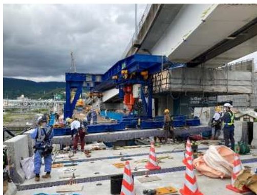
【床版取替機の活用状況】
