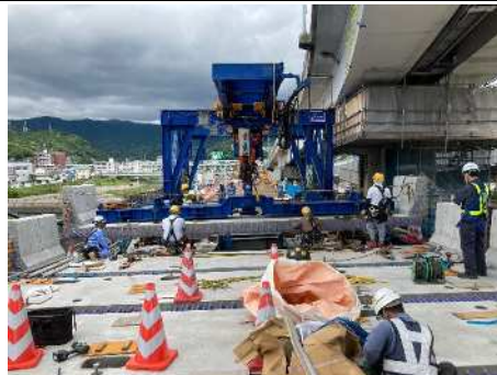
[萬丈橋下り線床版取替え状況 6月9日]
