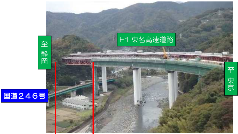
東名酒匂川橋の国道246号上空を通過している区間に工事用の足場を設置します
